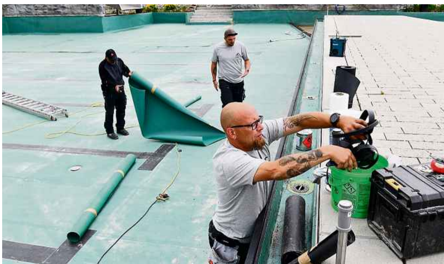
Die Folie im Becken und die Umlaufrinne werden ausgebessert
